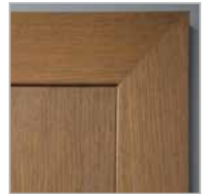
łączenie opasek pod kątem 45°
