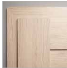
ramiak usłojenie pionowe, panele i płycina poziome
