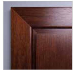
łączenie opasek pod kątem 45°
